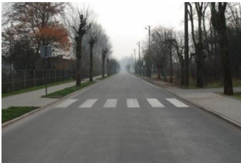
Rysunek 15. Ulica Karsznicka w Zduńskiej Woli - I etap po przebudowie
